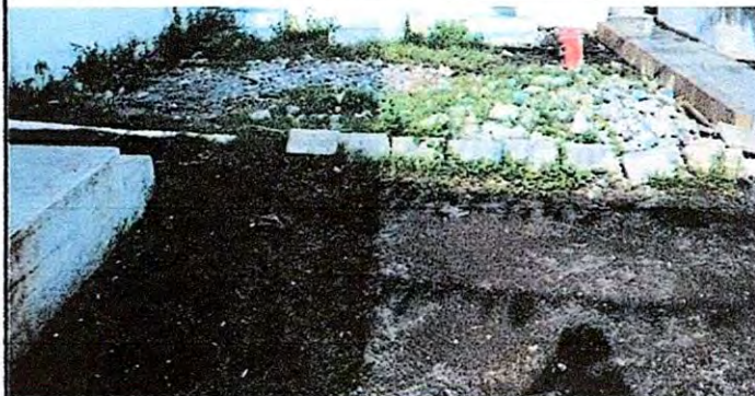
Foto 8. 6.5 Sustitución de piso de torta de concreto.
