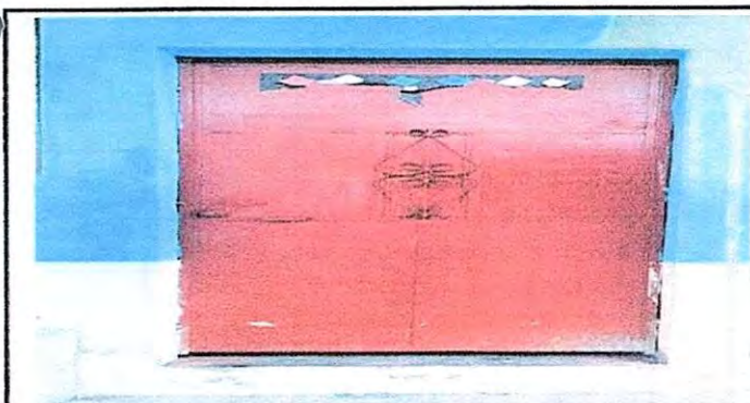
FOTO 5: AULA 4. 4.5 Sustitución de portón de metal.
