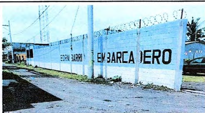
FOTO 9. 9.1 Pintura en muros exteriores e interiores.
