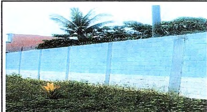
FOTO 10. 21.1 Repello en muro.
