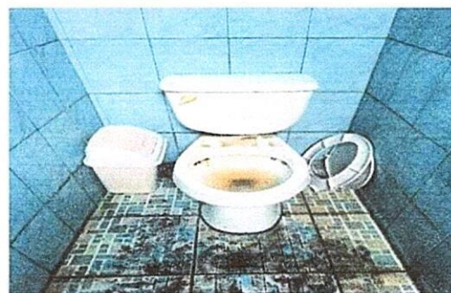
Foto 4: Inodoros en mal estado, Region 10.3 (Sustitución de inodoro), Region 19.15 (Instalación de inodoro).
