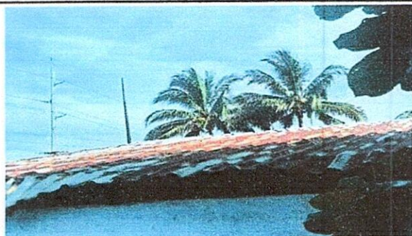
Foto 1: Enlaminado en mal estado, Region 1.1 (Sustitución de lamina por lamina troquelada aluzinc calibre 26), Region 1.3 (Sustitución de elementos de fijación), Region 19.8 (Instalación de lamina troquelada aluzinc) Region 19.10 (Desinstalación de lamina existente).
