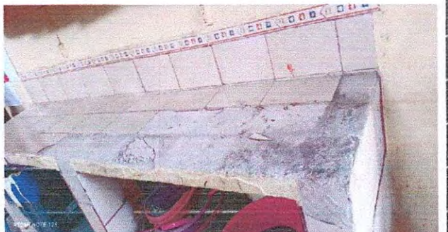
Foto 6: 20.8 REPARACIÓN DE AZULEJO DE COCINA
