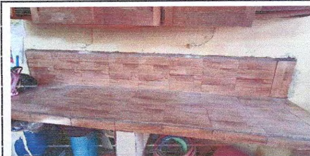
Foto 6: 20.8 REPARACIÓN DE AZULEJO DE COCINA
