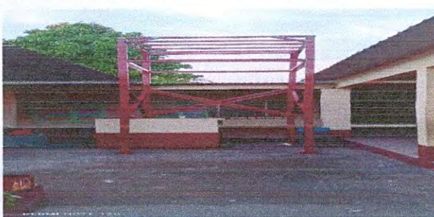
Foto 5: 18.3 SUSTITUCIÓN DE DEPÓSITO DE AGUA 1700 LT
