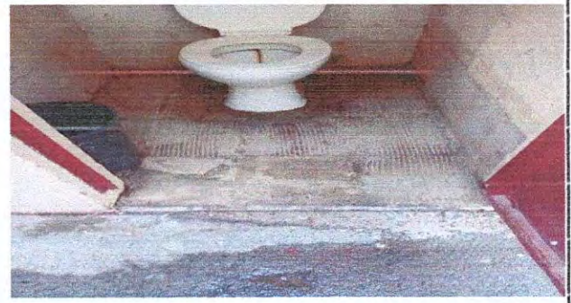
Foto 4: 4.3 SUSTITUCIÓN DE AZULEJO
