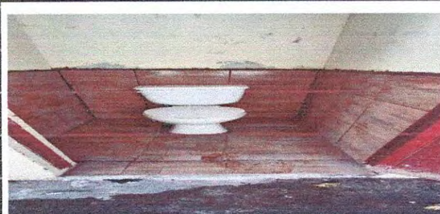
Foto 4: 4.3 SUSTITUCIÓN DE AZULEJO
