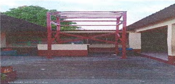
Foto 5: 18.3 SUSTITUCIÓN DE DEPÓSITO DE AGUA 1700 LT
