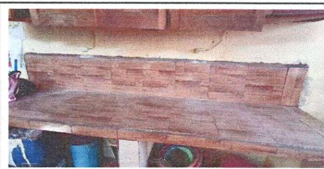
Foto 6: 20.8 REPARACIÓN DE AZULEJO DE COCINA
