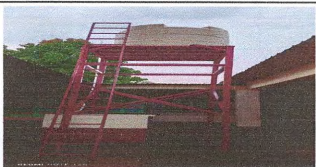
Foto 5: 18.3 SUSTITUCIÓN DE DEPÓSITO DE AGUA 1700 LT
