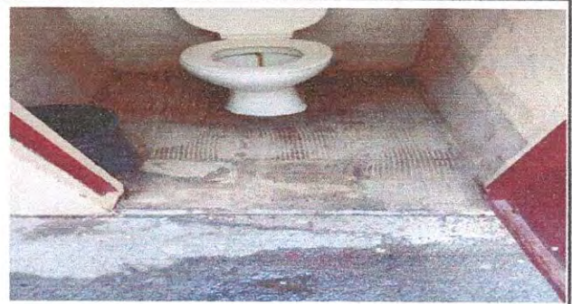
Foto 4: 4.3 SUSTITUCIÓN DE AZULEJO
