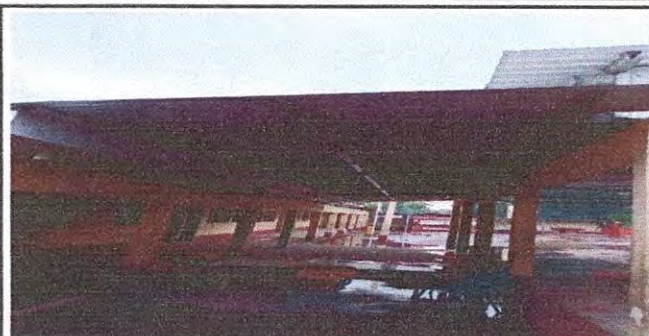
Foto1: 2.2 SUSTITUCION DE ESTRUCTURA DE MADERA POR METAL
