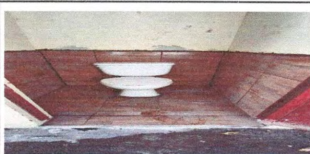
Foto 4: 4.3 SUSTITUCIÓN DE AZULEJO
