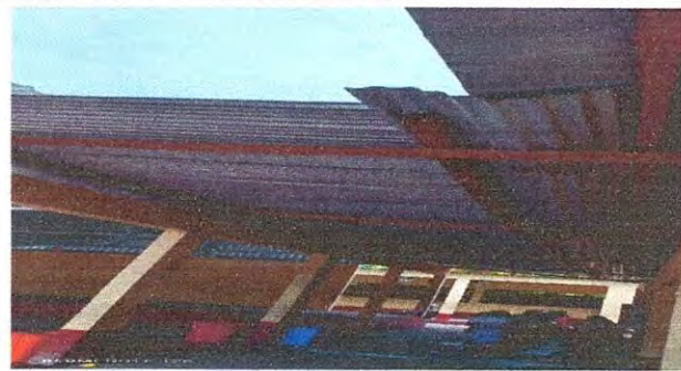
Foto 3: 7.1 SUSTITUCIÓN DE CANAL DE METAL
