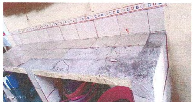
Foto 6: 20.8 REPARACIÓN DE AZULEJO DE COCINA
