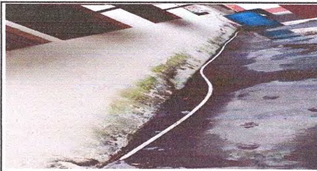
FOTO 8: 14.9 SUSTITUCION DE TUBERIA INEA PRINCIPAL
