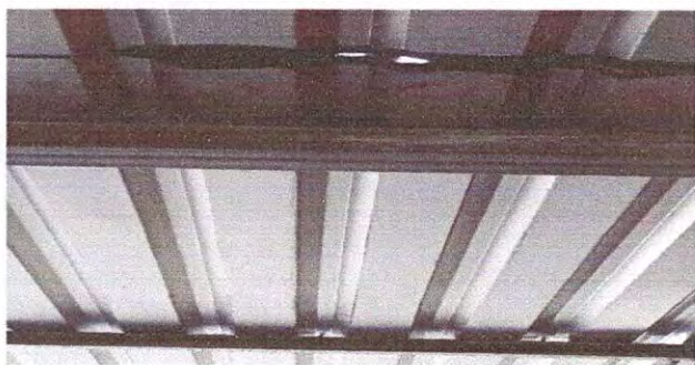
Foto 1: SUSTITUCIÓN DE LÁMINA 1.1
