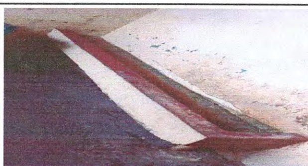
Foto 6: 14.1 MANTENIMIENTO DE REPOSADERAS
