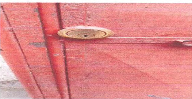
Foto 3: SUSTITUCIÓN DE CHAPA 4.2
