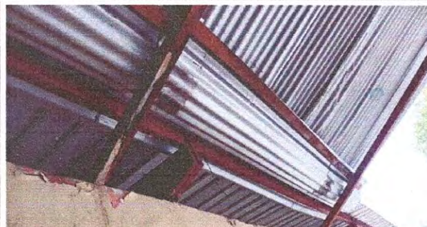
Foto 2: SUSTITUCIÓN DE ESTRUCTURA DE SOPORTE DE MADERA POR METAL 2.2
