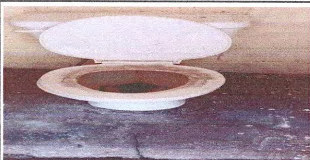
FOTO 7: 10.2 SUSTITUCION DE ACCESORIOS DE INODORO
