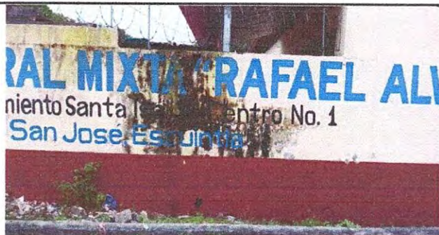
Foto 5: PINTURA DE MURO DE EXTERIORES E INTERIORES 9.1
