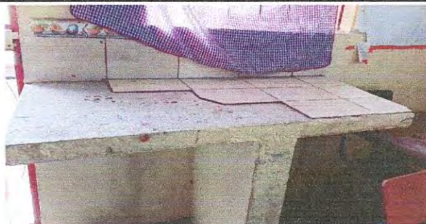
FOTO 13: 20.8 REPARACION DE AZULEJOS EN MUEBLES DE COCINA
