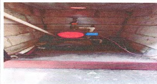
FOTO 9: 18.7 SUSTITUCION DE BOMBA AGUA
