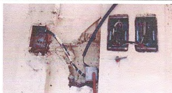
Foto 10: SUSTITUCION DE SISTEMA ELECTRICO
