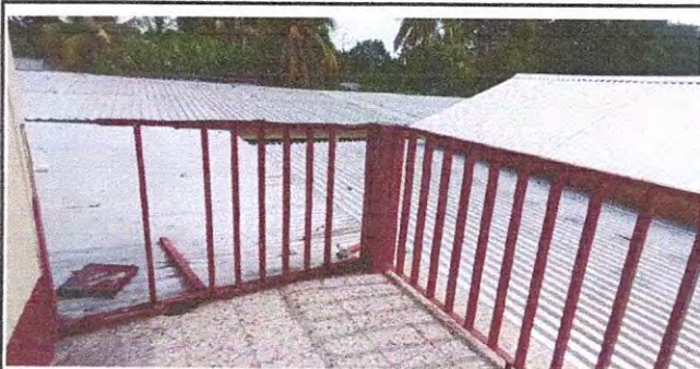
FOTO 11: 11.1 MANTENIMINETO DE BARANDAS 11.2 SUSTITUCION DE BARANDAS
