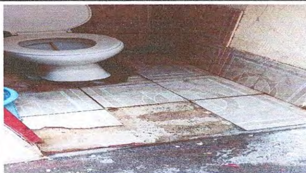
FOTO 14: 13.1 SUSTITUCIÓN DE AZULEJO
