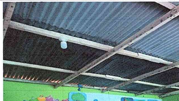
Foto 2: Estructura de madera en mal estado, Region 2.2 (Sustitución de estructura de soporte de madera por metal) (Instalación de estructura portante de metal). Region 19.7 (Desinstalación de estructura portante).
