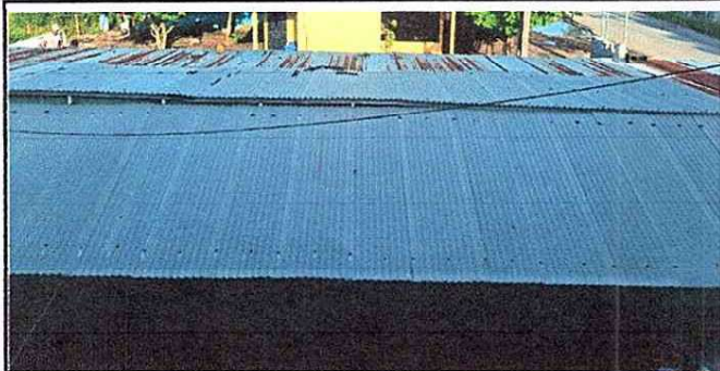
Foto 1: Enlaminado en mal estado, Region 1.1 (Sustitucion de lamina por lamina troquelada aluzinc calibre 26) Region 19.8 (Instalación de lamina troquelada aluzinc) Region 19.10 (Desinstalación de lamina existente).
