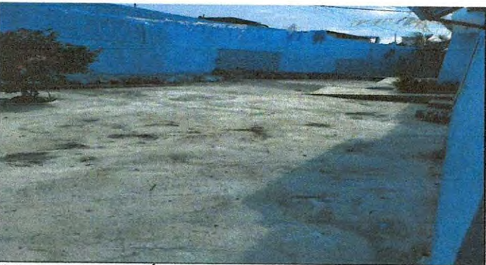
Foto 11: 16 LOSA DE PÁTIO
