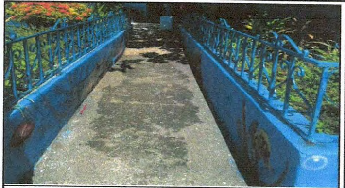
Foto 8: 11 MANTENIMIENTO A BARANDAS
