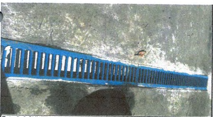
Foto 5: 8 CUNETTA DE CONCRETO
