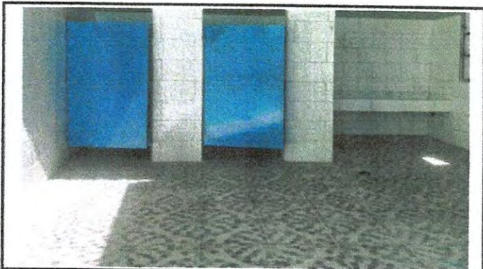
Foto 4: 6 PISO 6.8 SUSTITUCIÓN DE PISO CERÁMICO
