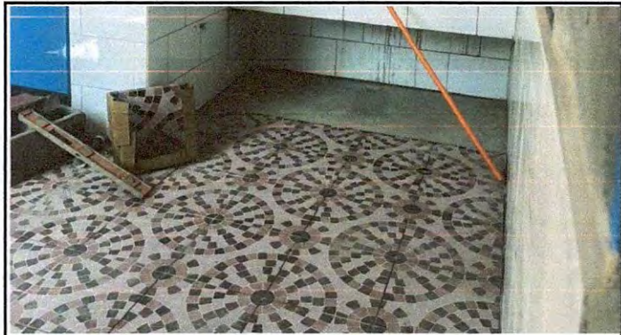
Foto 4: 6 PISO 6.8 SUSTITUCIÓN DE PISO CERÁMICO
