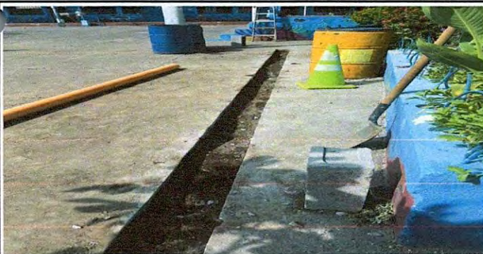
Foto 5: 8 CUNETAS DE CONCRETO
