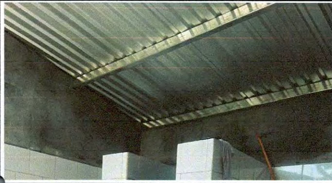
Foto 1: CUBIERTA DE LÁMINA. 2 ESTRUCTURA DE TECHO
