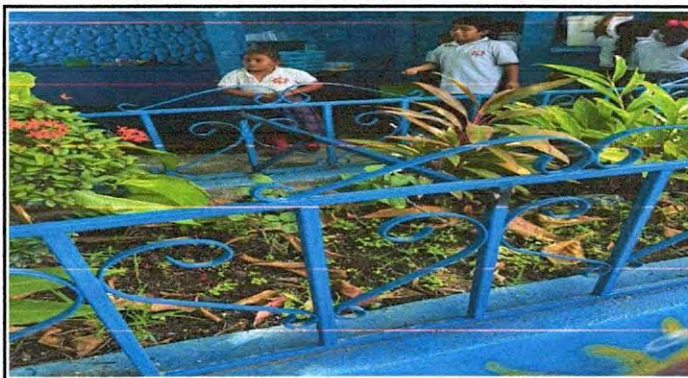
Foto 8: 11 MANTENIMIENTO A BARANDAS
