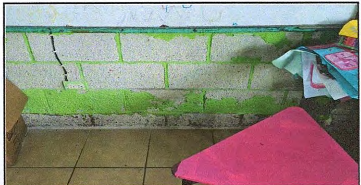
Foto 12: 17 REPARACIÓN DE SISTEMA ELÉCTRICO
