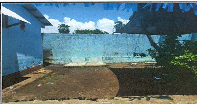
Foto 11: 16 LOSA DE PATIO
