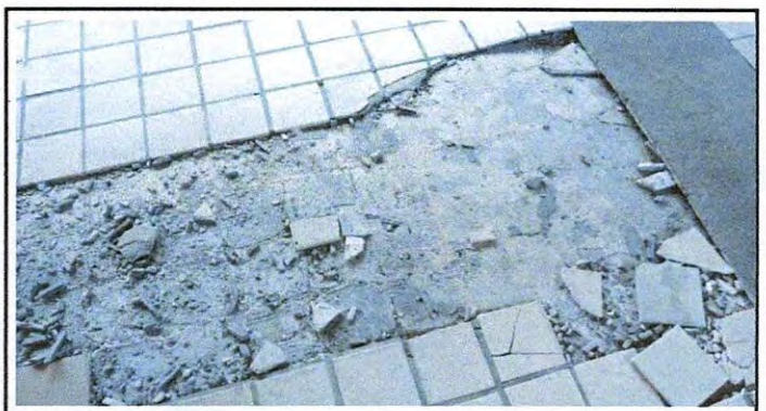
Foto 4: 6 PISO 6.8 SUSTITUCIÓN DE PISO CERÁMICO
