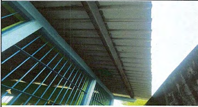
Foto 1: 1 CUBIERTA DE LÁMINA. 2 ESTRUCTURA DE TECHO.
