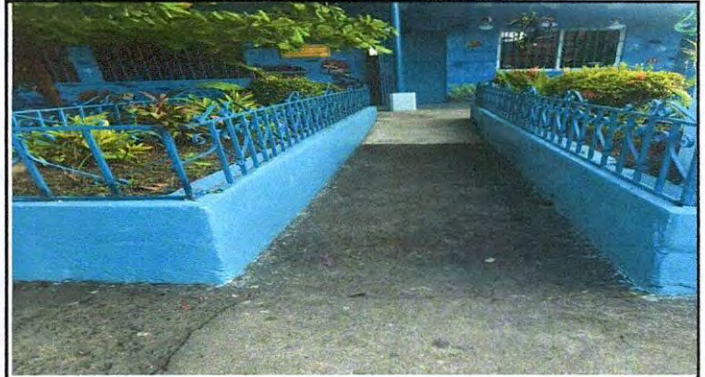
Foto 8: 11 MANTENIMIENTO A BARANDAS.
