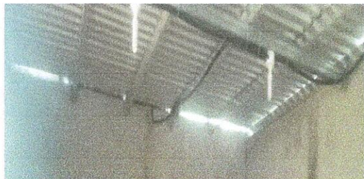
Foto 1: Terminación de colocación de lámina y energía eléctrica, Region 1.1 (Sustitución de lámina, por lámina troquelada aluzinc calibre 26), Region 19.8 (Instalación de lámina troquelada aluzinc)
