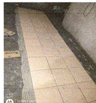
Foto 4: Colocación de piso Ceramico, Region 6.8 (Sustitución de piso ceramico)
