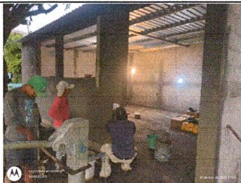
Foto 3: Colocación de Puerta de metal, Region 4.3 (Sustitución de puerta) Region 19.3 (Fabricación e instalación de puertas de metal en módulos).
