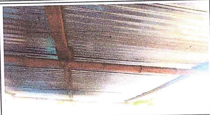
Foto 2: Estructura de madera en mal estado, Region 2.2 (Sustitución de estructura de soporte de madera, por metal), Region 19.7 (Instalación de estructura portante de metal)
