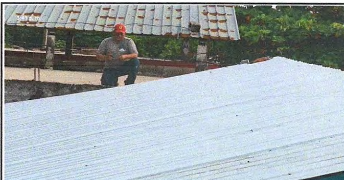
Foto 6: Colocación de tornillo para lámina troquelada. Renglón 1.3 (Sustitución de elementos de fijación).
