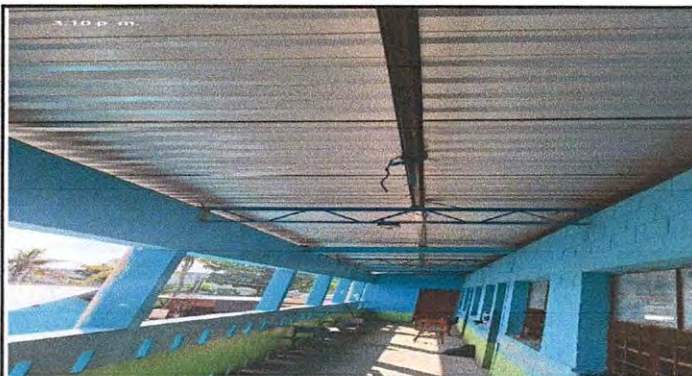
Foto 3: Cambio de lámina a lámina troquelada en el corredor del segundo nivel. Renglón 19.8 (Instalación de lámina troquelada aluzinc).
