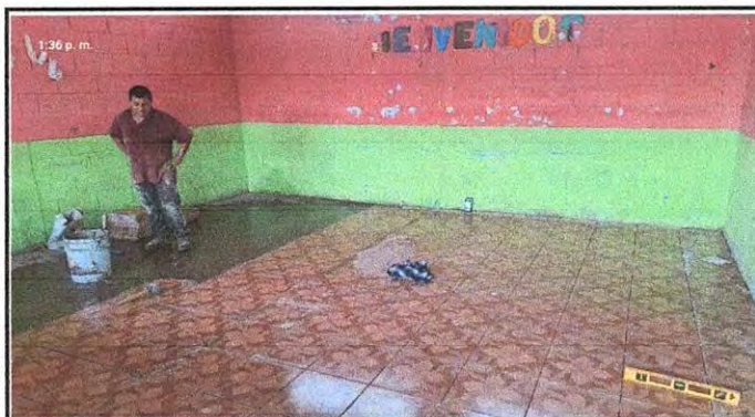
Foto 4: Colocación del piso cerámico en el aula de 2 B. Renglón 6.8 (Sustitución de piso cerámico).
