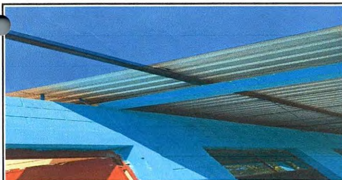
Foto 5: Colocación de lámina de troquelada aluzinc calibre 26. Renglón 1.1 (Sustitución de lámina, por lámina troquelada aluzinc calibre 26).
