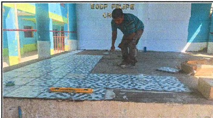
Foto 2: Colocación de piso cerámico en el escenario. Renglón 6.8 (Sustitución de piso cerámico).
