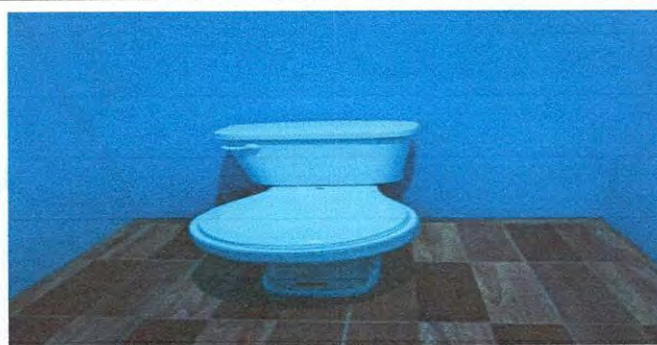
Foto 2: 10.2 SUSTITUCION DE ACCESORIOS DE INODORO
