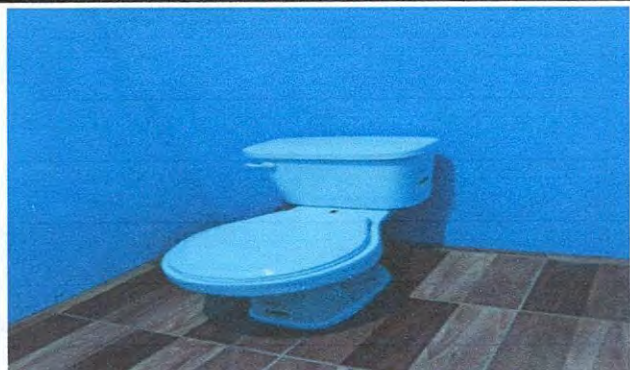
Foto 1: 10.2 SUSTITUCION DE ACCESORIOS DE INODORO
