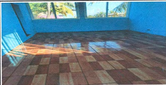
Foto 6: 6.8 SUSTITUCION DE PISO CERAMICO
