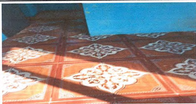
Foto 5: 6.8 SUSTITUCION DE PISO CERAMICO
