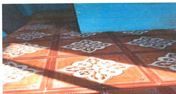
Foto 6: 6.8 SUSTITUCION DE PISO CERAMICO
