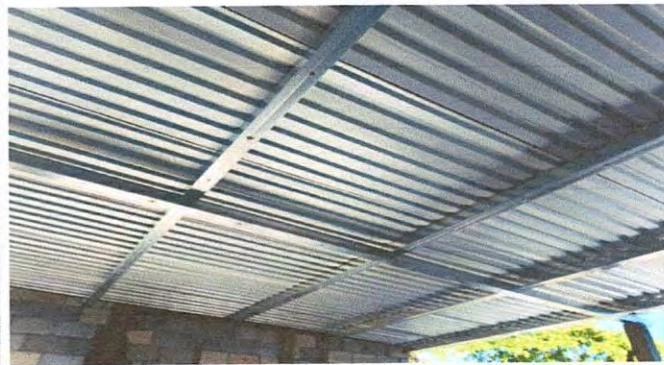
Foto 4: 2.3 SUSTITUCION DE ESTRUCTURA DE METAL POR METAL
