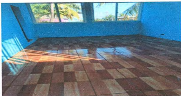
Foto 5: 6.8 SUSTITUCION DE PISO CERAMICO
