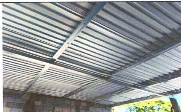
Foto 4: 2.3 SUSTITUCION DE ESTRUCTURA DE METAL POR METAL
