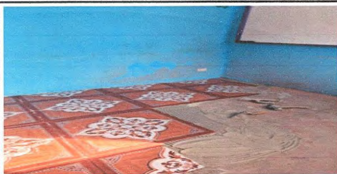
Foto 5: 6.8 SUSTITUCION DE PISO CERAMICO
