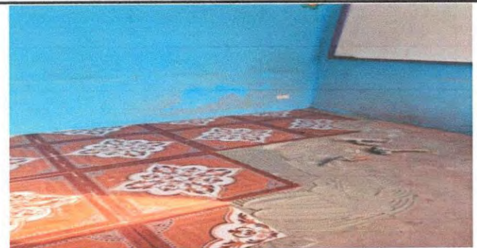
Foto 6: 6.8 SUSTITUCION DE PISO CERAMICO
