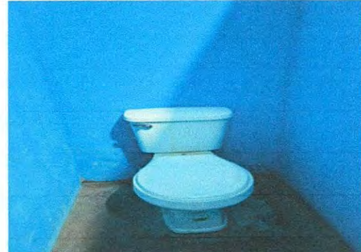
Foto 2: 10.2 SUSTITUCION DE ACCESORIOS DE INODORO
