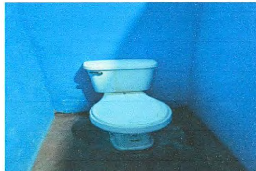
Foto 2: Sustrución de sanitario
