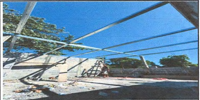
Foto 4: 2.3 SUSTITUCION DE ESTRUCTURA DE METAL POR METAL
