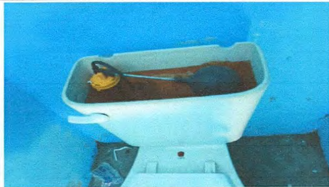
Foto 1: 10.2 SUSTITUCION DE ACCESORIOS DE INODORO
