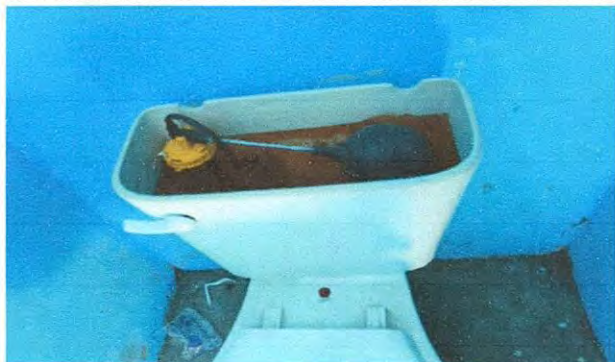
Foto1: Sustrución de sanitario
