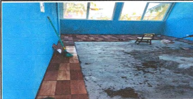
Foto 6: 6.8 SUSTITUCION DE PISO CERAMICO
