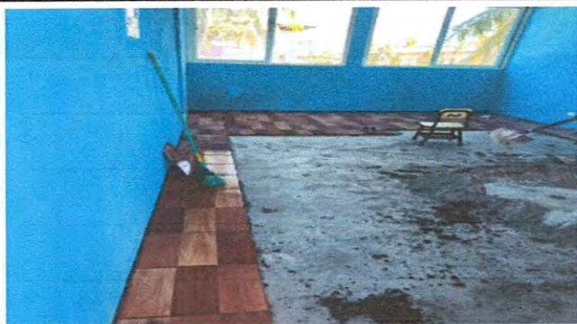
Foto 5: 6.8 SUSTITUCION DE PISO CERAMICO
