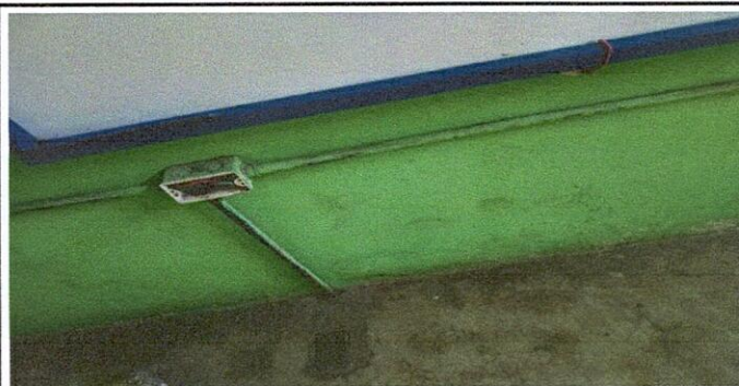
Foto 6: SUSTITUCION DE DUCTO ELÉCTRICO + ACCESORIOS
