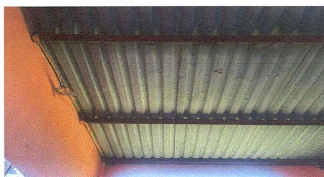
Foto 4: SUSTITUCION DE DUCTO ELÉCTRICO + ACCESORIOS
