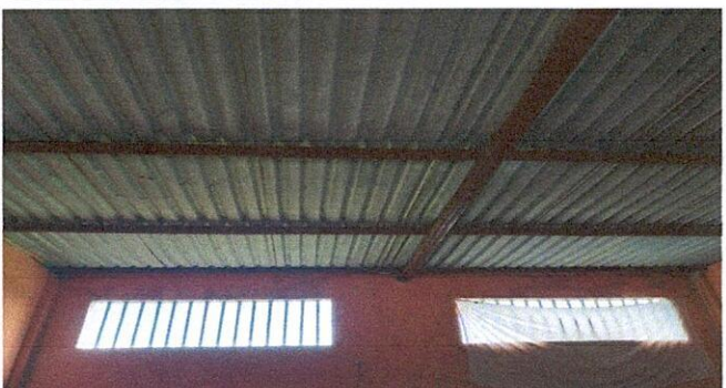
Foto 3: CAMBIO DE LÁMINA EXISTENTE POR LÁMINA TROQUELADA ALUZINC 26. DESINSTALACIÓN DE ESTRUCTURA PORTANTE POR ESTRUCTURA DE METAL.
