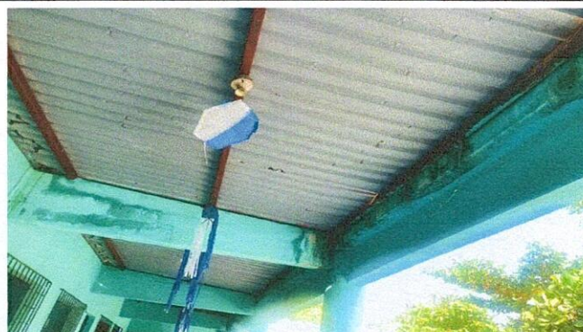
Foto 2: SUSTITUCION DE DUCTO ELÉCTRICO + ACCESORIOS
