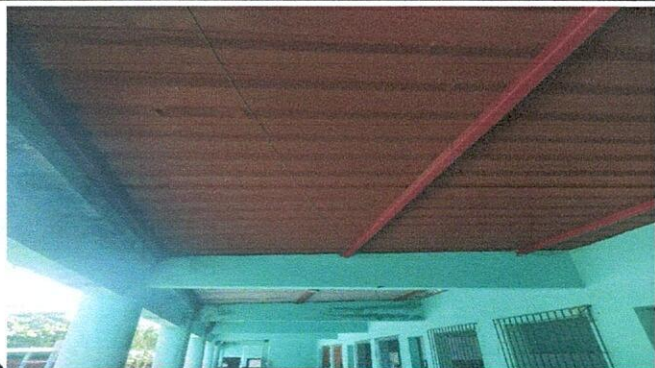
Foto 1: CAMBIO DE LÁMINA EXISTENTE POR LÁMINA TROQUELADA ALUZINC 26. DESINSTALACIÓN DE ESTRUCTURA PORTANTE POR ESTRUCTURA DE METAL.
