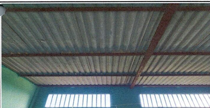
Foto 5: CAMBIO DE LÁMINA EXISTENTE POR LÁMINA TROQUELADA ALUZINC 26. DESINSTALACIÓN DE ESTRUCTURA PORTANTE POR ESTRUCTURA DE METAL.
