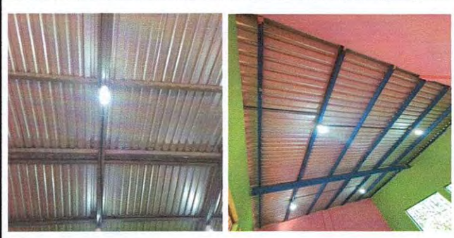
Foto 4: Sustitución de plafoneras
