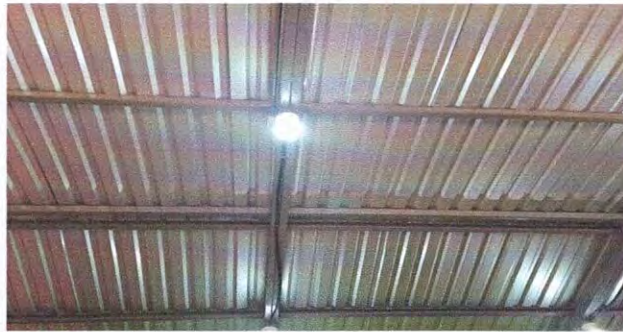
Foto 4: Reparación de sistema eléctrico
