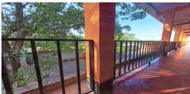
Foto 5: Mantenimiento en barandal
