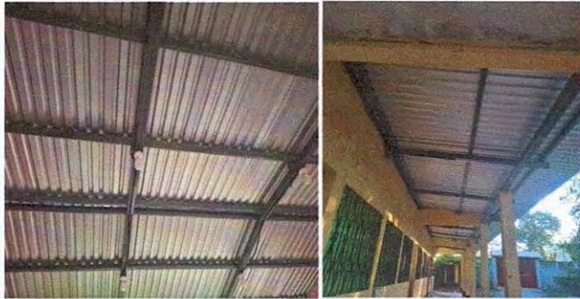
Foto1: Cambio de lámina en salones y corredor de preprimaria.
