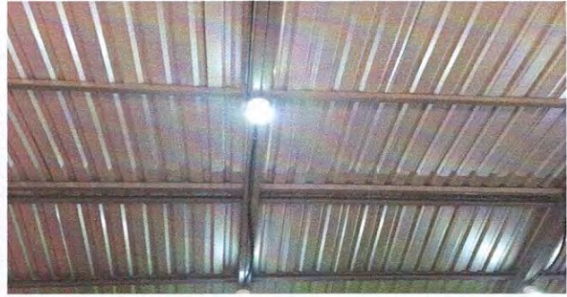
Foto 4: Reparación de sistema eléctrico
