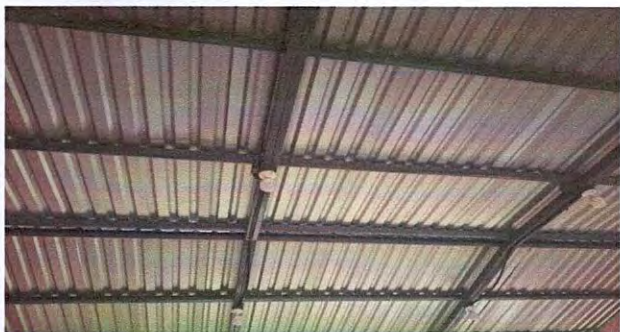
Foto 3: Mantenimiento a estructura de soporte de metal
