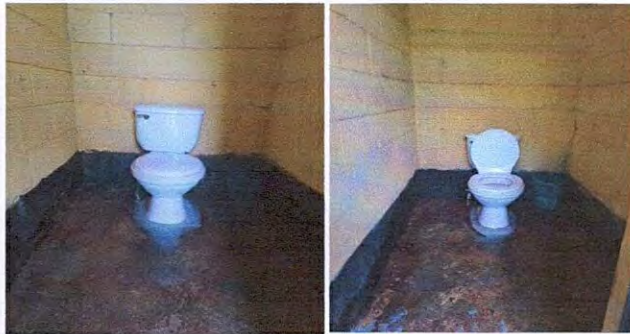
Foto1: Sustitución de inodoros
