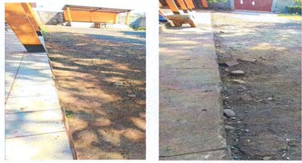
Foto 2: Sustitución de tubería PVC
