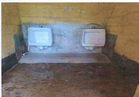
Foto 5: Sustitución de mingitorios
