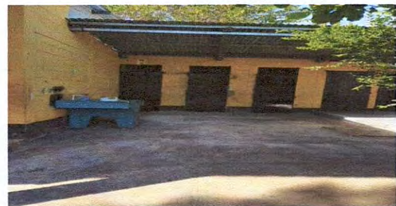
Foto 6: : Reparación de plancha de concreto en patio
