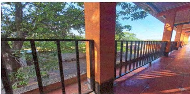
Foto 5: Mantenimiento en barandal
