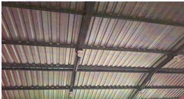
Foto 3: Mantenimiento a estructura de soporte de metal
