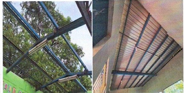
Foto 4: Sustitución de plafoneras
