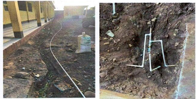
Foto 2: Sustitución de tubería PVC
