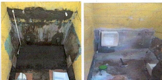
Foto 5: Sustitución de mingitorios
