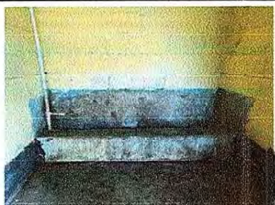
Foto 5: Sustrucción de mingitorio
