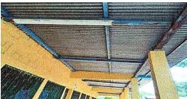
Foto 3: Mantenimiento a estructura de soporte de metal
