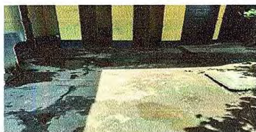
Foto 6: Reparación de planchas de concreto de patio
