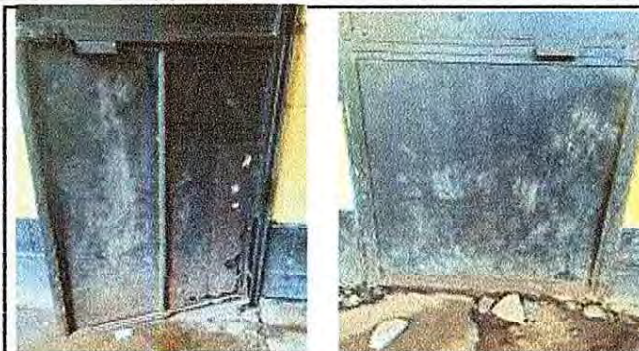
Foto 2: Fabricación de instalación de puerta de metal de baños
