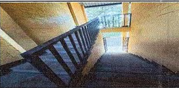
Foto 5: Mantenimiento en barandal.
