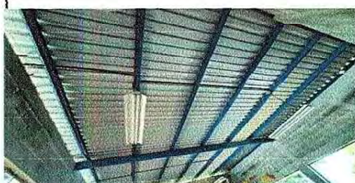
Foto 4: Sustrucción de plafoneras
