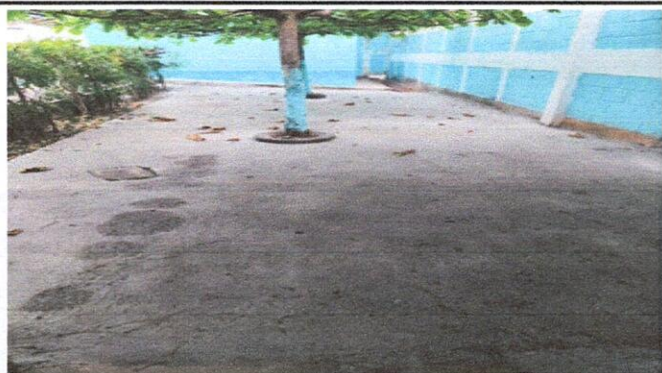
foto 3: 16.1 reparacion de plancha de concreto de patio
