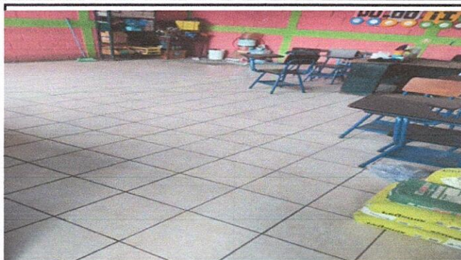
foto 2: 6.5 Sustitucion de torta de concreto
