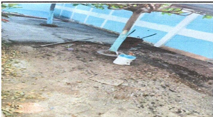
foto 3: 16.1 reparacion de plancha de concreto de patio
