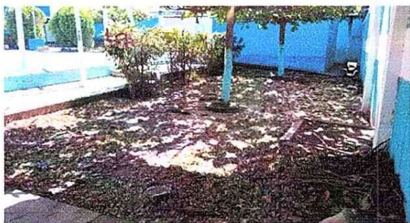
FOTO 3: 16 losa de patio
