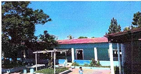
Foto 1: 1 Cubierta de lamina
