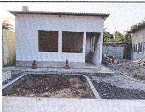
Foto 4: Repello de muro
