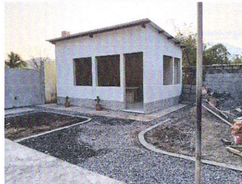
Foto 2: Reparación de Planchas de concreto de patio, Repello de muro
