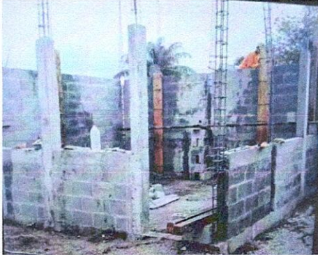
Foto 1: Reparación de muro perimetral de block con tubo HG y malla galvanizada, soleras intermedias y columnas
