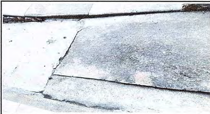
Foto 2: 16. Losa de patio
