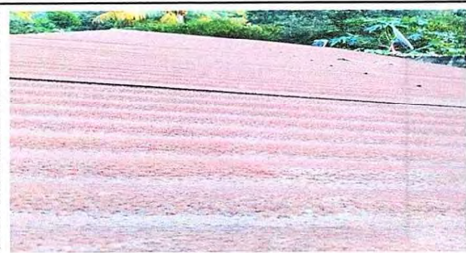
Foto1: 1. Cubierta de Lamina
