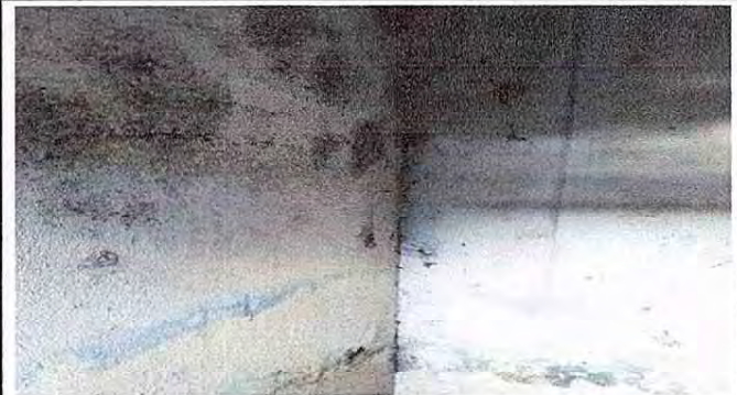
Foto 4: 9. Pintura en Exteriores e interiores de muros
