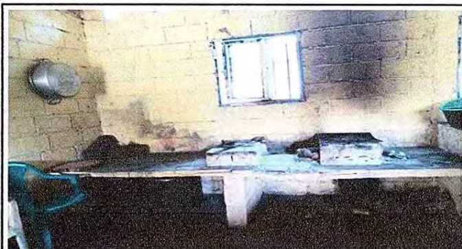
Foto 4: 20. reparacion de cocina
