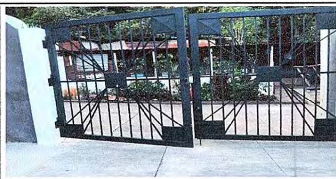
Foto 5: 12. Mantenimiento a portones
