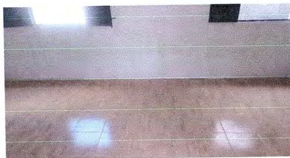
Foto 6: Reparación de piso cerámico
