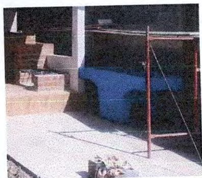
Foto 9: Reparación de planchas de concreto de patio
