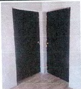
Foto 3: Sustitución de puerta
