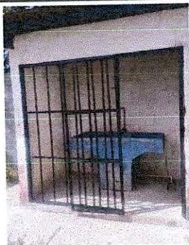
Foto:17 Instalacion de puerta de rejas.
