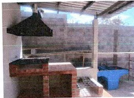
Foto 14: Sustitución de estufa rural (completa) incluye chimenea y plancha de metal.
