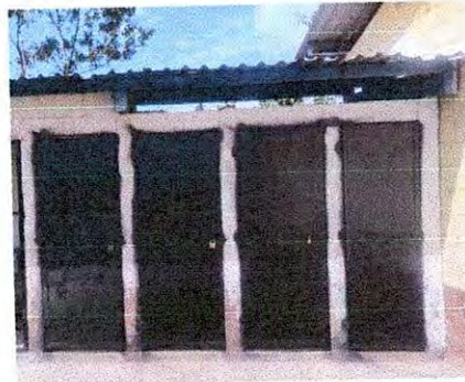
Foto 8: Mantenimiento a estructura (lijado, cambio de tubo , cepillado, sujeciones, aplicación de pintura)
