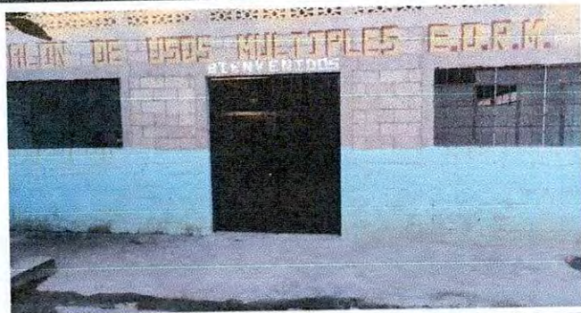
Foto 5: Sustitución de portón de metal.
