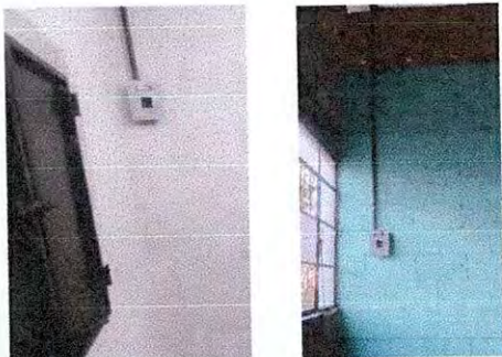
Foto13: Instalación de tablero y flipones
