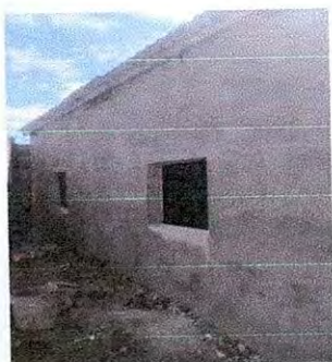
Foto 15: Reparación de repello y cernido en paredes
