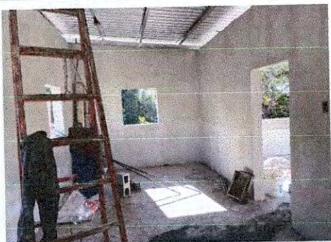
Foto 15: Reparación de repello y cernido en paredes
