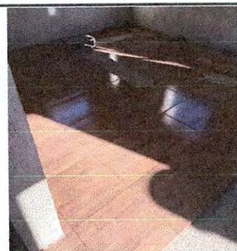
Foto 6: Reparación de piso cerámico
