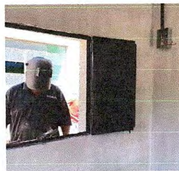
Foto 4: piso: Sustitución de ventanas de madera por metal
