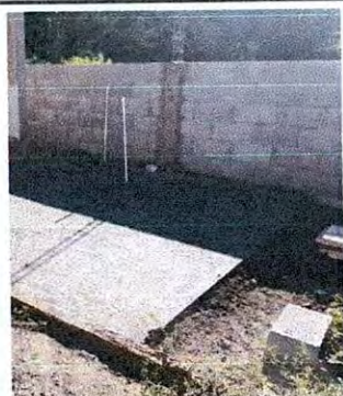
Foto 9: Reparación de planchas de concreto de patio
