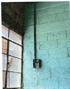
Foto 13: Instalación de tablero y flipones
