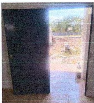
Foto 3: Sustitución de puerta
