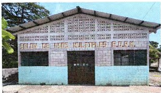
Foto 5: Sustitución de portón de metal.
