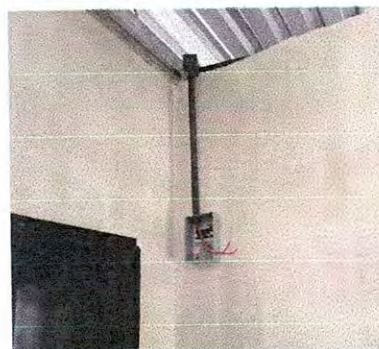
Foto 10: Instalación de unidades luz (incluye interruptor, ducto y cable eléctrico)
