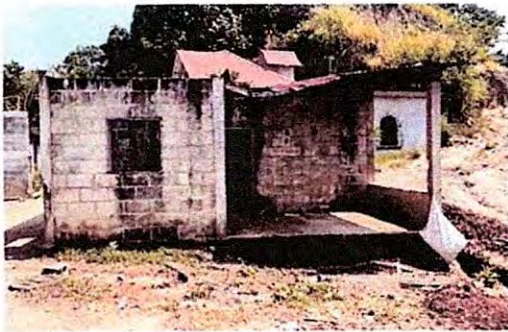
Foto 15: Reparación de repello y cernido en paredes
