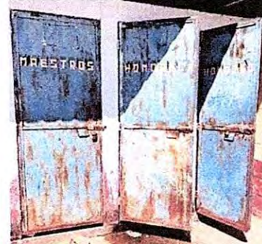
Foto 8: Mantenimiento a estructura (Iljado, cambio de tubo , cepillado, sujecciones, aplicación de pintura)
