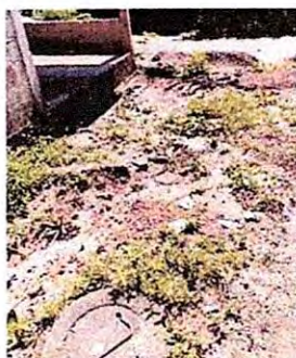
Foto 9: Reparación de planchas de concreto de patio
