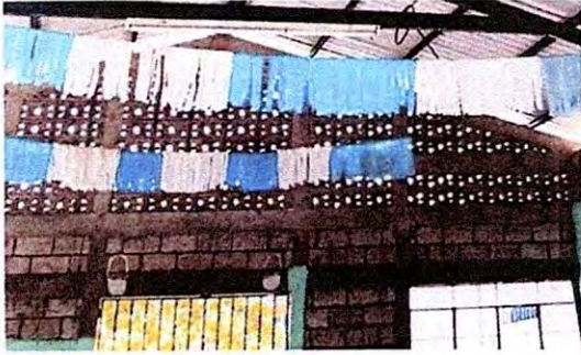
Foto13: Instalación de tablero y flipones
