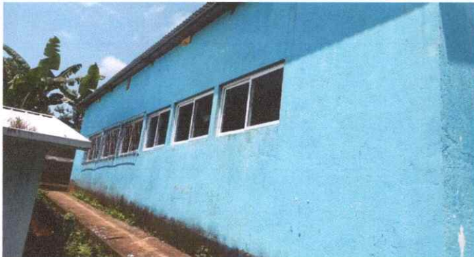
Foto 3: SUSTITUCION DE ESTRUCTURA DE METAL DE VENTANAS
