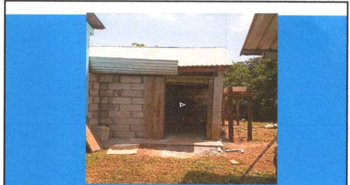
Foto 2: SUSTITUCION DE PUERTA DE METAL PARA COCINA
