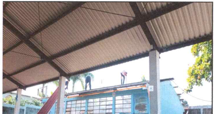
Foto 4: SUSTITUCION DE CANAL DE METAL
