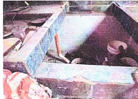
Foto 2: 20.10 Sustitución de pila de cemento de dos lavadero
