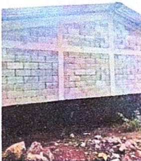
Foto 3: 21.1 Repello en muro
