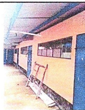
Foto 6: 17.4 Sustitución de focos ahorradores 17.11 Reparación de cableado eléctrico 17.12 Sustitución de ducto eléctrico + accesorios
