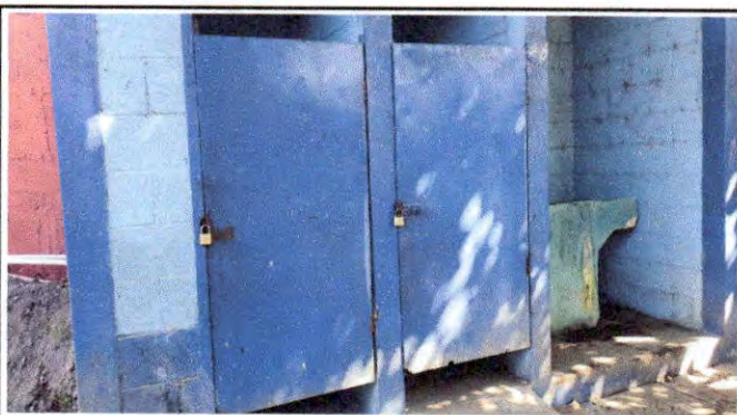
Foto 5: Modulo de baños
