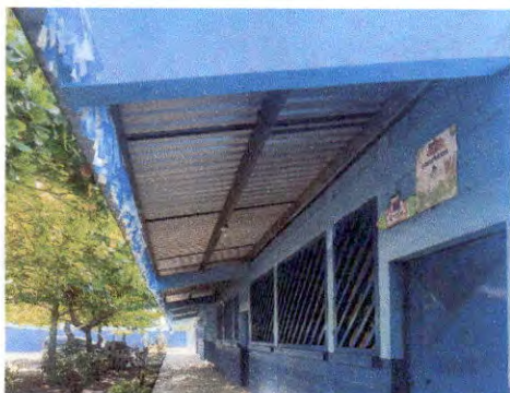
Foto 3: Techo de pasillos
