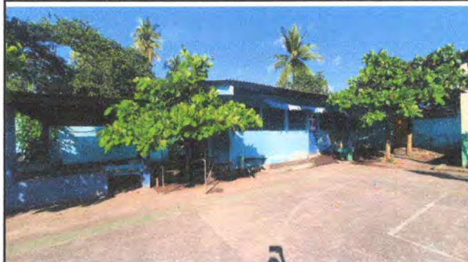
Foto 4: cocina y aulas existentes
