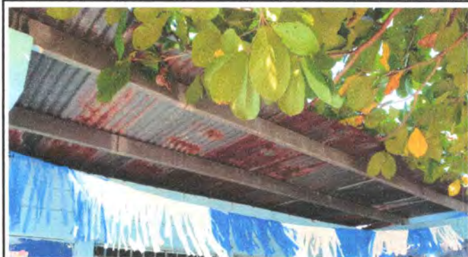
Foto 5: Techo de aula en mal estado.
