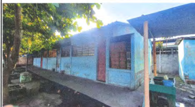
Foto 10: Aulas y bodega
