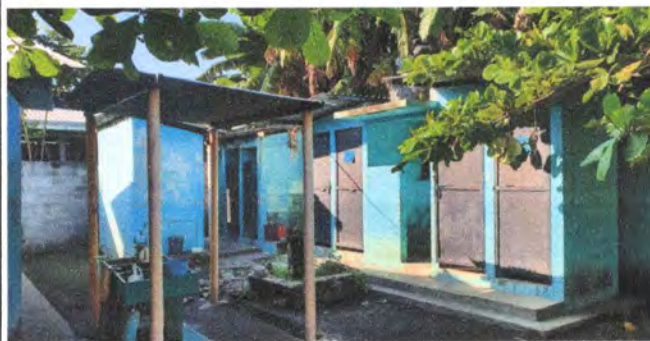
Foto 2: Modulo de baños y pila
