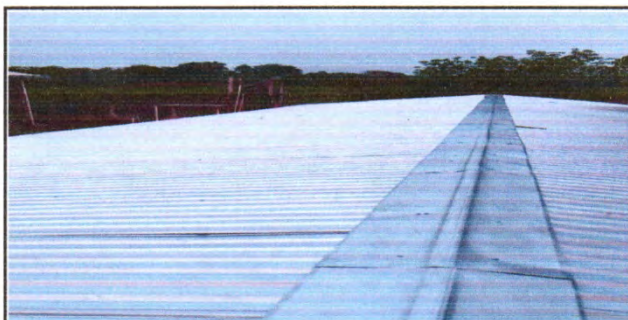
Foto 4: FINALIZACIÓN DE SUSTITUCION DE LAMINA TROQUELADA
