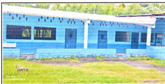
Foto 5: FINALIZACIÓN DE SUSTITUCION DE LAMINA TROQUELADA
