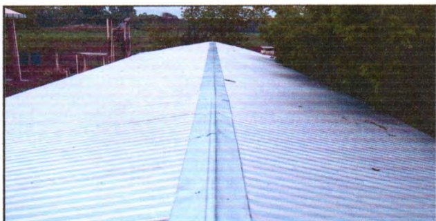
FOTO 3: FINALIZACIÓN DE SUSTITUCION DE LAMINA TROQUELADA
