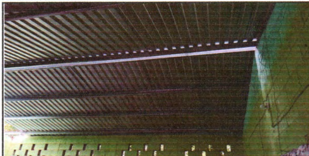
FOTO 1: FINALIZACIÓN DE SOPORTE DE METAL
