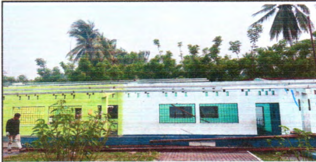
FOTO 2: SUSTITUCIÓN DE SOPORTE DE METAL POR METAL
