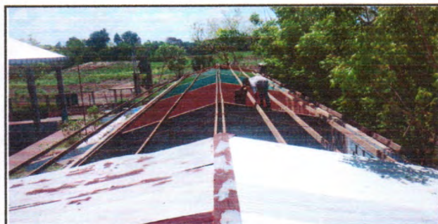
FOTO 3: INSTALACIÓN DE SOPORTE DE METAL
