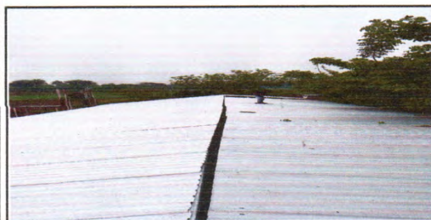
Foto 5: INSTALACIÓN DE LAMINA TROQUELADA
