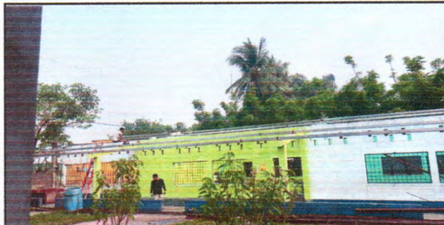
FOTO 1: SUSTITUCIÓN DE SOPORTE DE METAL POR METAL
