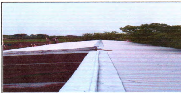
Foto 6: INSTALACIÓN DE LAMINA TROQUELADA
