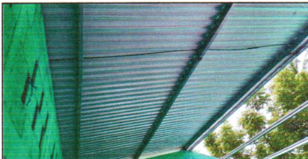
Foto 4: INSTALACION DE LAMINA TROQUELADA
