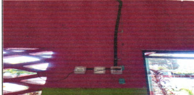
FINALIZACIÓN DE INTERRUPTORES
