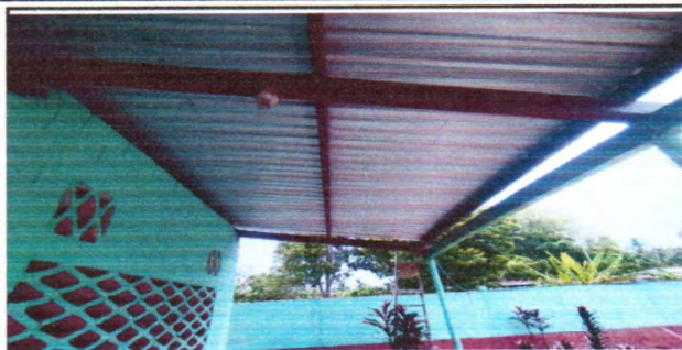
FINALIZACIÓN DE SUSTITUCIÓN DE SOPORTE DE MADERA POR SOPORTE DE METAL
