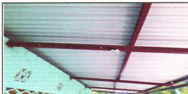
FINALIZACIÓN DE SISTEMA ELECTRICO
