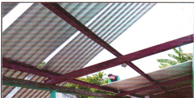
foto 3 2.1 Mantenimiento a estructura de soporte de metal
