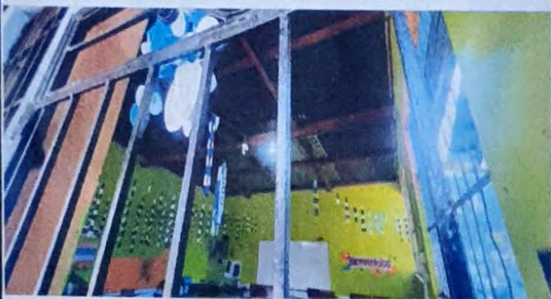
Foto 3. CAMBIO DE TECHO EN AULA
