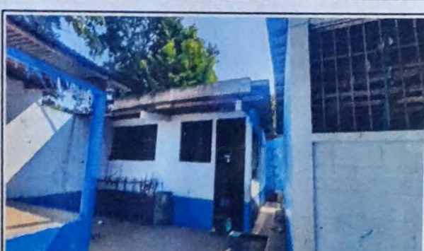
Foto 10: AULA A INTERVENIR CON CAMBIO DE TECHO
