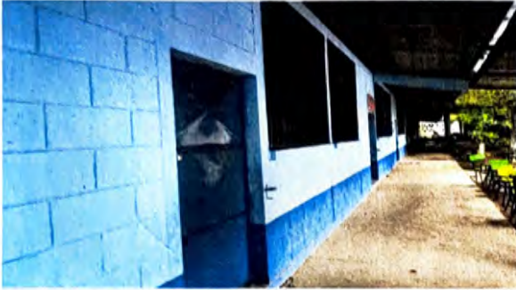
Foto1: 5.1 MANTENIMIENTO A ESTRUCTURA DE METAL DE VENTANA
