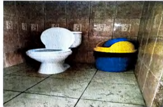
Foto 4: 10.3 SUSTITUCIÓN DE INODORO
