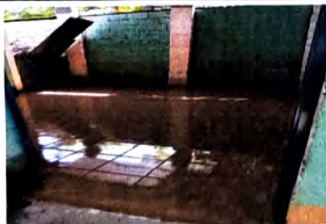
Foto 6: 6.8 SUSTITUCIÓN DE PISO CERAMICO
