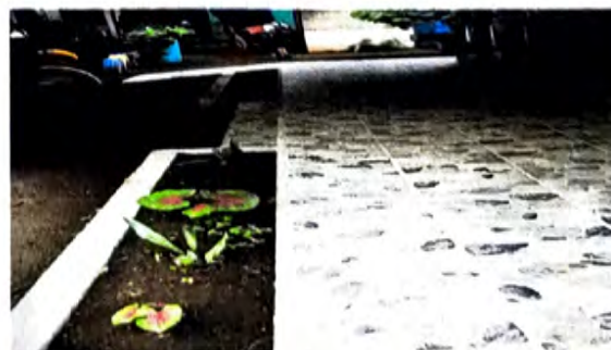
Foto 6: 6.8 SUSTITUCIÓN DE PISO CERAMICO
