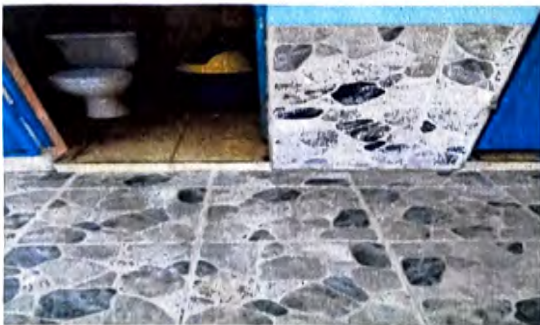
Foto 5: 10.3 SUSTITUCIÓN DE INODORO
