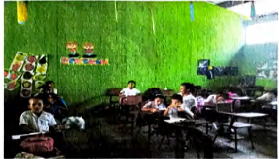
Foto 3: 9.1 PINTURA EN MUROS EXTERIORES E INTERIOS
