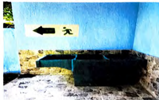
Foto 6: 20.1 SUSTITUCIÓN DE PILA DE CEMENTO DE DOS LAVADEROS 14.13 SUSTITUCIÓN DE CHORRO
