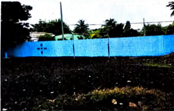
Foto 3: 9.1 PINTURA EN MUROS EXTERIORES E INTERIOS
