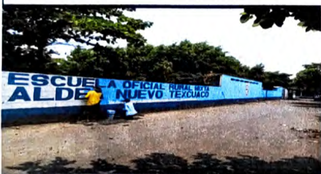
Foto 3: 9.1 PINTURA EN MUROS EXTERIORES E INTERIOS
