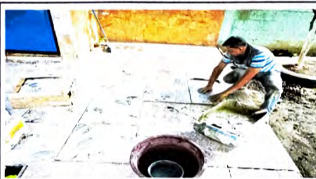
Foto 6: 6.8 SUSTITUCIÓN DE PISO CERAMICO
