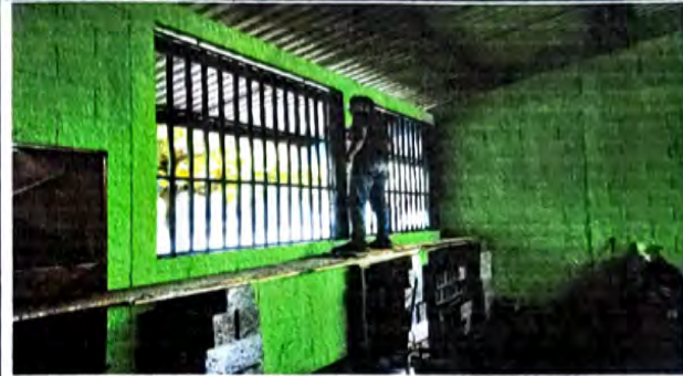
Foto 2: 5.1 MANTENIMIENTO A ESTRUCTURA DE METAL DE VENTANA
