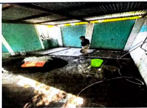
Foto 5: 6.1 REPARACIÓN DE PISO DE TORTA DE CONCRETO
