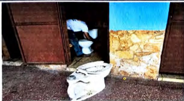
Foto 5: 10.3 SUSTITUCIÓN DE INODORO
