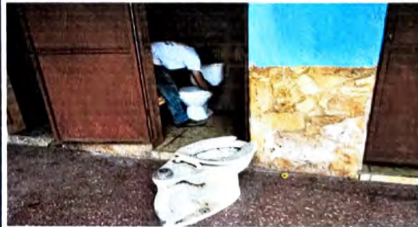
Foto 4: 10.3 SUSTITUCIÓN DE INODORO
