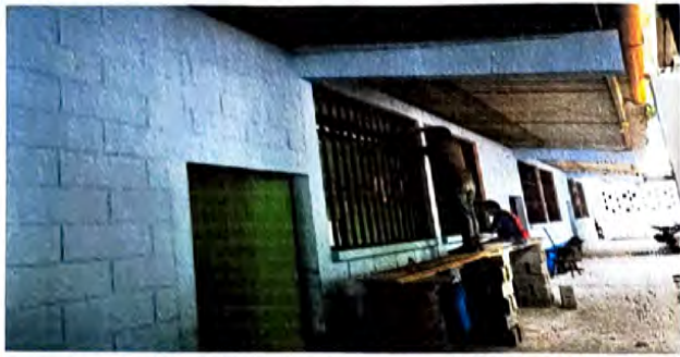
Foto 1: 5.1 MANTENIMIENTO A ESTRUCTURA DE METAL DE VENTANA
