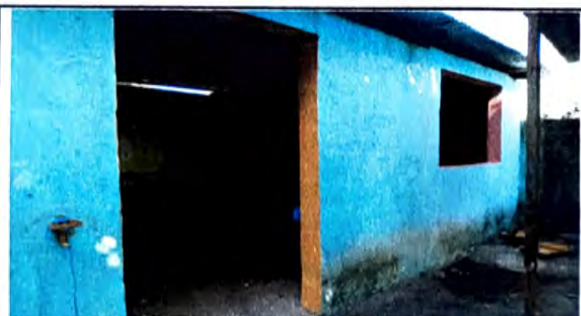
Foto 3: 9.1 PINTURA EN MUROS EXTERIORES E INTERIOS
