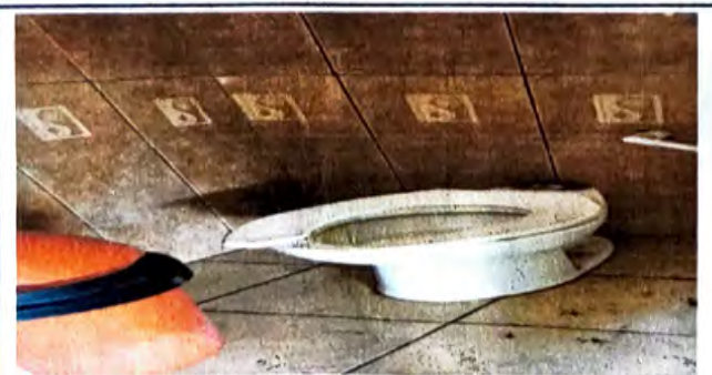
Foto 5: 10.3 SUSTITUCIÓN DE INODORO
