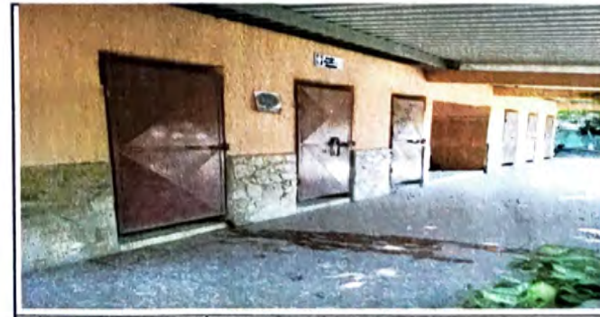
Foto 6: 6.8 SUSTITUCIÓN DE PISO CERAMICO
