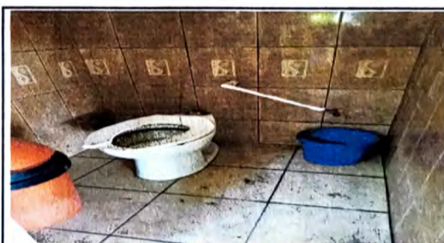
Foto 4: 10.3 SUSTITUCIÓN DE INODORO
