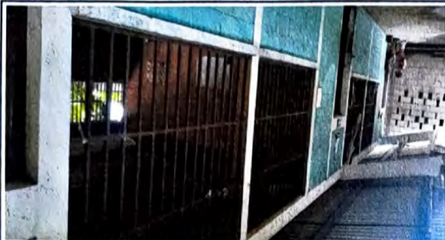
Foto 1: 5.1 MANTENIMIENTO A ESTRUCTURA DE METAL DE VENTANA
