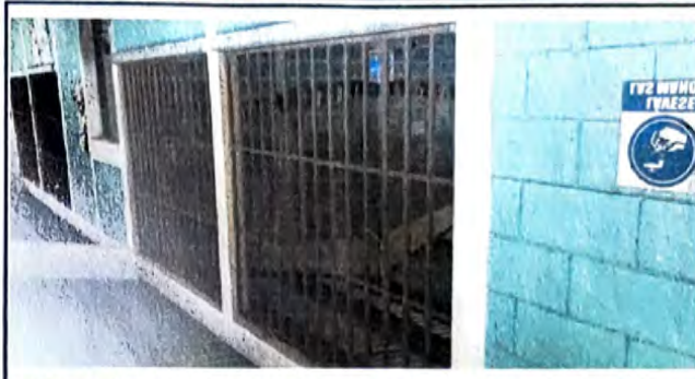
Foto 2: 5.1 MANTENIMIENTO A ESTRUCTURA DE METAL DE VENTANA
