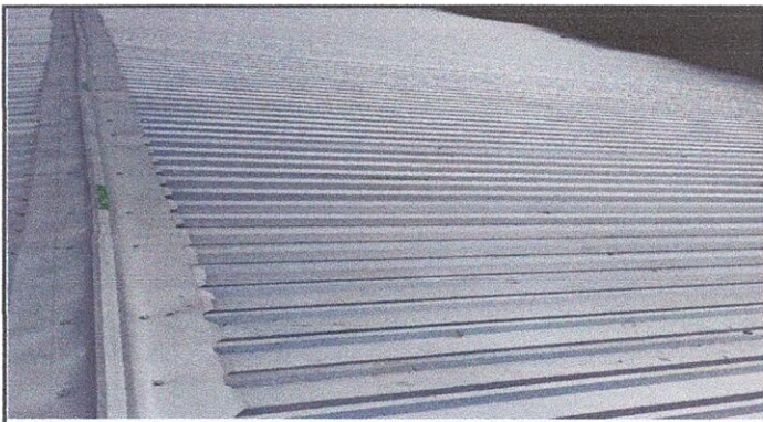
Foto 3: 1.1 SUSTITUCIÓN DE LÁMINA, POR LÁMINA TROQUELADA
