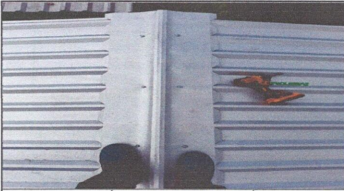
Foto1: 1.3 SUSTITUCIÓN DE ELEMENTOS DE FIJACIÓN
