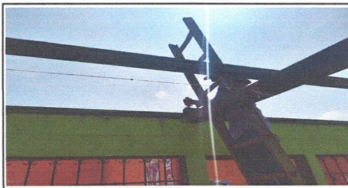
Foto 6: 2.3 SUSTITUCIÓN DE ESTRUCTURA DE SOPORTE DE METAL POR METAL
