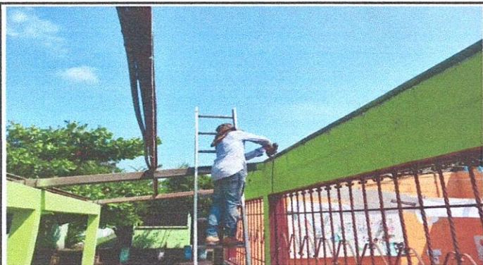
Foto1: 1.3 SUSTITUCIÓN DE ELEMENTOS DE FIJACIÓN
