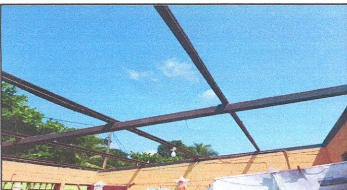
Foto 3: 1.1 SUSTITUCIÓN DE LÁMINA, POR LÁMINA TROQUELADA
