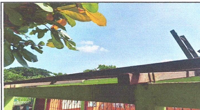
Foto 4: 1.3 SUSTITUCIÓN DE ELEMENTOS DE FIJACIÓN
