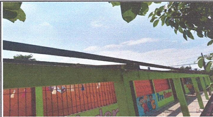
Foto 2: 1.2 SUSTITUCIÓN DE CAPOTE DE LÁMINA PARA LÁMINA TROQUELADA
