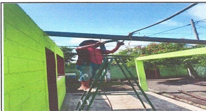
Foto 5: 2.3 SUSTITUCIÓN DE ESTRUCTURA DE SOPORTE DE METAL POR METAL
