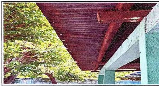
Foto 6: 1.1 SUSTITUCIÓN DE LÁMINA, POR LÁMINA TROQUELADA
