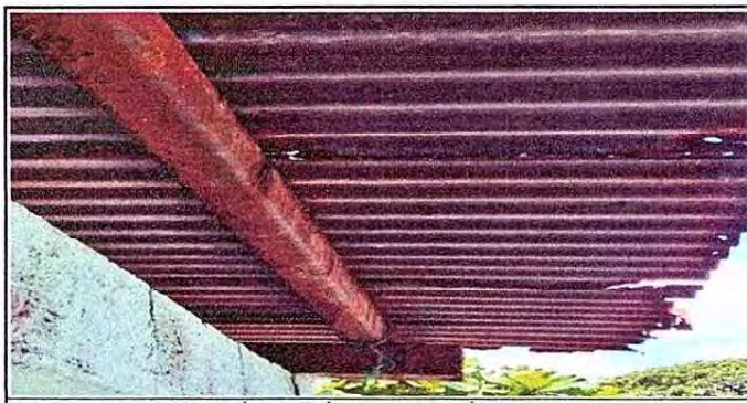
Foto 5: 1.1 SUSTITUCIÓN DE LÁMINA, POR LÁMINA TROQUELADA
