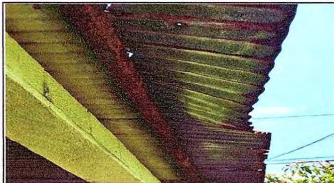
Foto 4: 1.1 SUSTITUCIÓN DE LÁMINA, POR LÁMINA TROQUELADA
