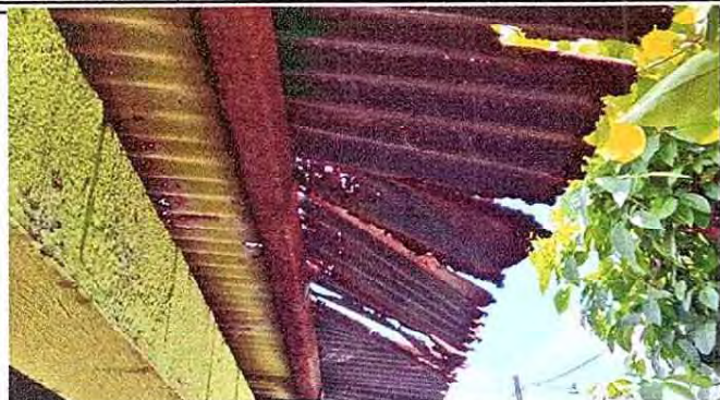
Foto1: 1.1 SUSTITUCIÓN DE LÁMINA, POR LÁMINA TROQUELADA
