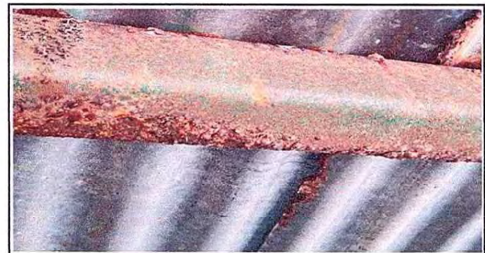
Foto 6: 2.3 SUSTITUCIÓN DE ESTRUCTURA DE SOPORTE DE METAL POR METAL
