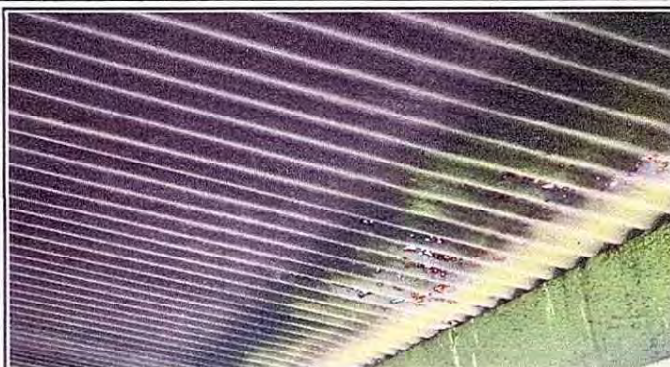
Foto 2: 1.1 SUSTITUCIÓN DE LÁMINA, POR LÁMINA TROQUELADA
