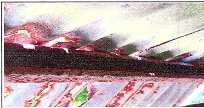
Foto 5: 2.3 SUSTITUCIÓN DE ESTRUCTURA DE SOPORTE DE METAL POR METAL
