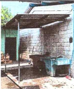
Foto1: 1.1 Sustitución de lámina, por lámina troquelada aluzinc calibre 26. 2.2 Sustitución de estructura de soporte de metal, por metal 10.5 Sustitución lavamanos
