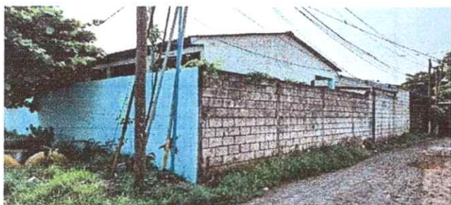
Foto 5: 22.1 Reparación de muro de contención
