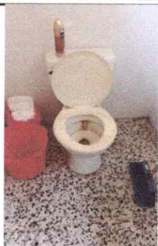
Foto 1: ANTES SERVICIOS SANITARIOS
