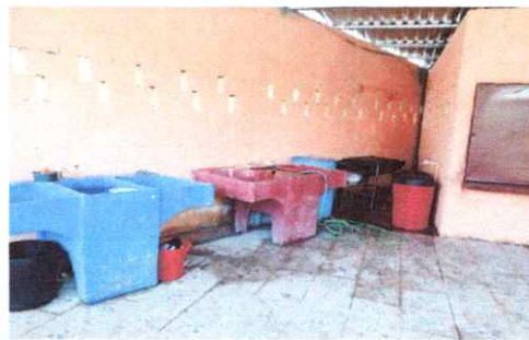
Foto 4: PILAS DE COCINA
