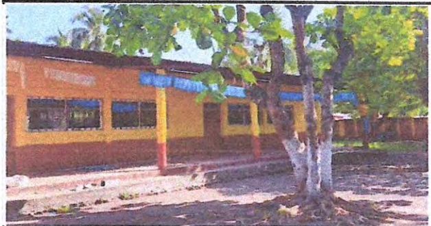
Foto 4: 9.1 Pintura en muros de exteriores ( de toda la escuela)
