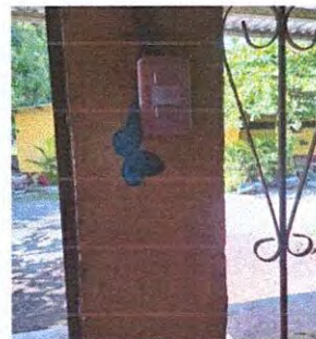
Foto 8: 17.6 Sustitución de interruptores simples
