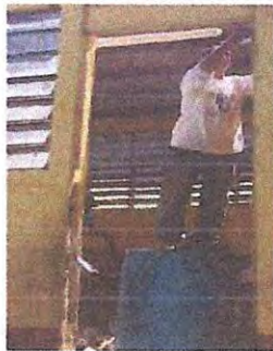
Foto 3: 4.1 Mantenimiento a estructura (fijado, cambio de tubo, cepillado, sujeciones, aplicación de pintura)
