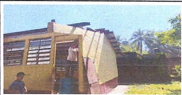
Foto 2: 1.1 Sustitución de lámina por lámina troquelada aluzinc calibre 26 (20 pies)
