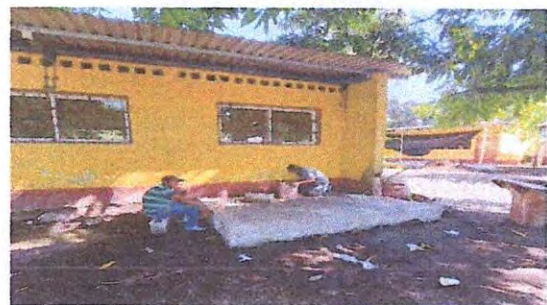
Foto 6: 16.1 Reparación de plancha de concreto de patio
