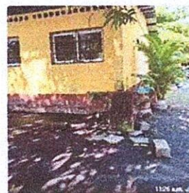
Foto 6: 16.1 Reparación de plancha de concreto de patio
