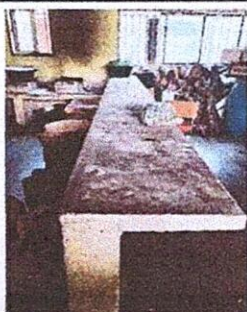
Foto 11: 20.8 Reparación de azulejo en mueble de cocina
