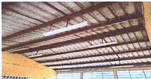
Foto 7: 17.4 Sustitución de focos ahorradores (se sustituirán en cuatro salones, dos corredores y la dirección)
