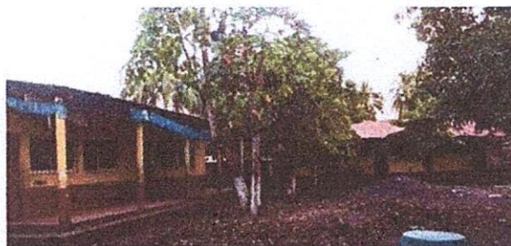
Foto 4: 9.1 PINTURA EN MUROS EXTERIORES (de toda la escuela)
