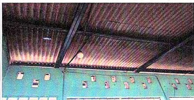
Foto1: Mantenimiento de soporte de metal
