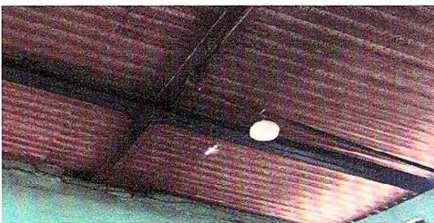
Foto 3: Sustitucion de lamparas tipo led
