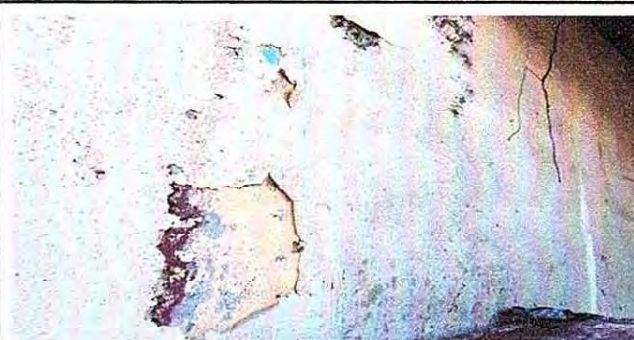
Foto 4: Pintura en muros exteriores e interiores
