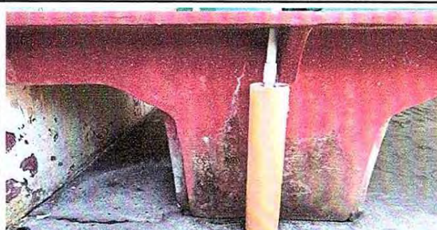
Foto 6: Sustitucion de pilas de dos lavaderos
