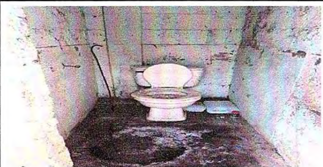
Foto 5: Sustitucion de inodoros
