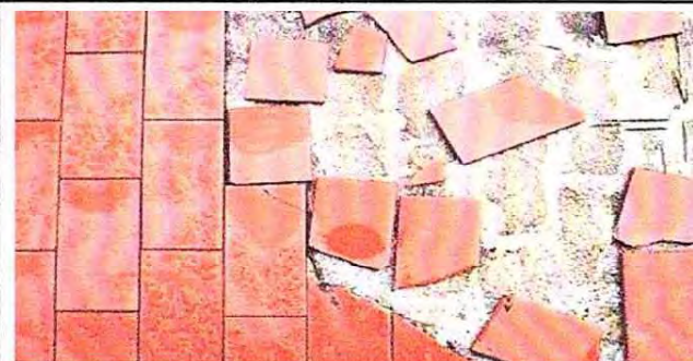
Foto 6: Sustitucion de azulejos
