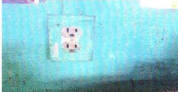
Foto 4: Sustitucion de interruptores
