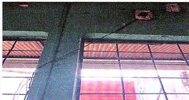
Foto 2: Sustitucion de balcones
